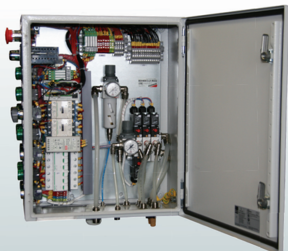
Шкаф управления установкой для запрессовки подшипников Автомобильная промышленность
